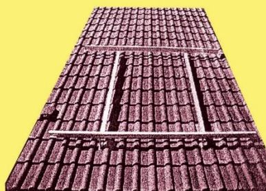
Nosilna konstrukcija za montažo nad strešno kritino
